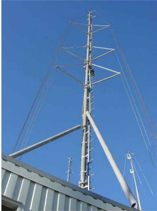
Figura 1. Vista della struttura portante con la nuova configurazione per gli stralli.
