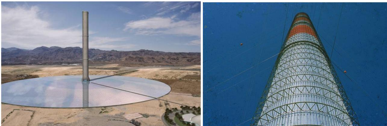
Fig. 1: un esempio di torre solare (a sinistra) e, a destra, un esempio di torre strallata irrigidita da anelli reticolari.
